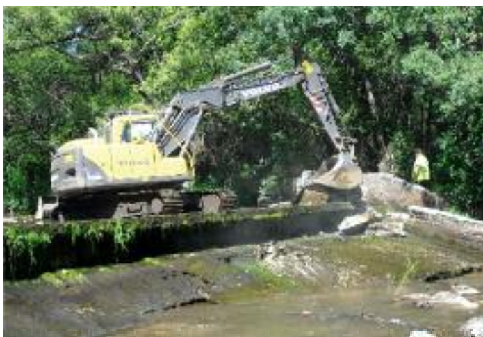
Figura 4.7 Demolición azud Pinilla. CH Tajo
