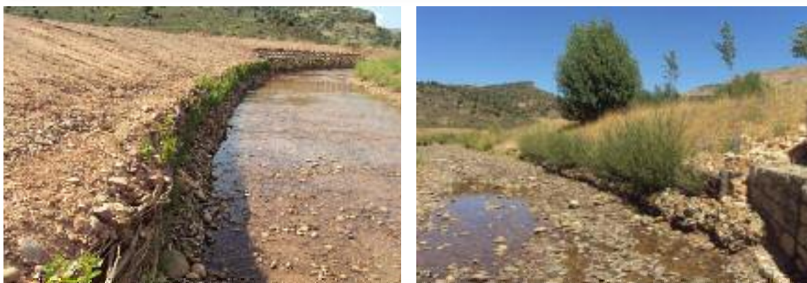
Figura 6.16 Empalizada trenzada y gavión flexible y muro krainer al fondo. Río Linares en Riba de Saélices (Guadalajara). Intervención recientemente finalizada (sup.) y evolución un año después (inf.)
