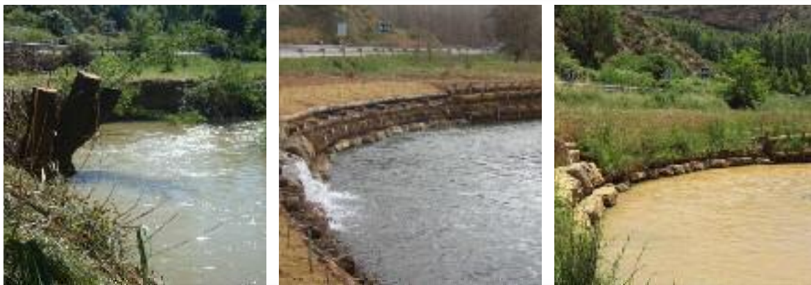
Figura 6.17 Evolución de la intervención en el Río Turia (T.M. Libros, Teruel): (sup.) situación inicial del tramo de actuación; (med.) obra recién terminada con muro Krainer y empalizada de biorrollos; (inf.) situación a los 7 meses de finalizar
